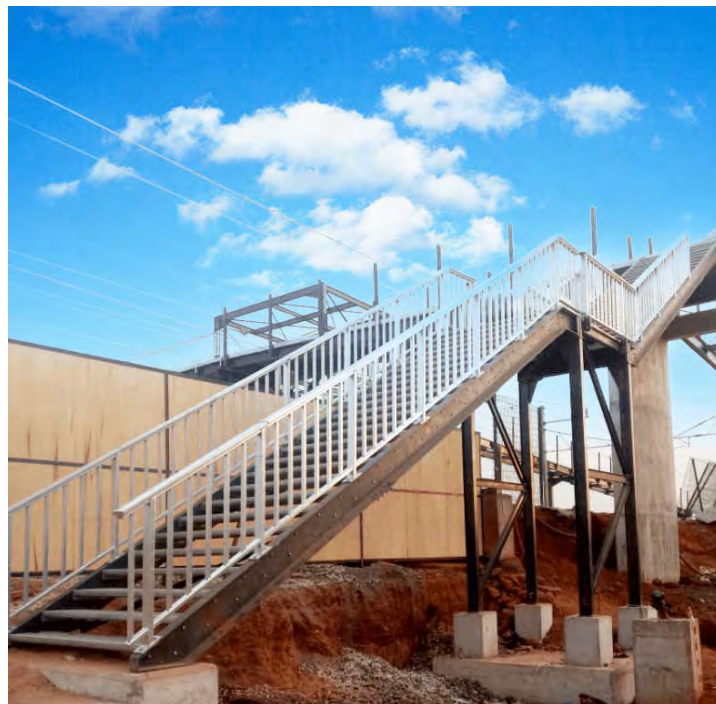
Garde-Corps sur passerelle piétonne ferroviaire - Sénégal
